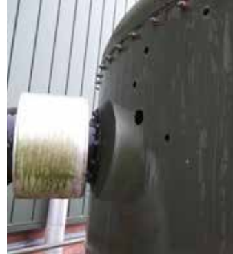
Perforación en la pared
